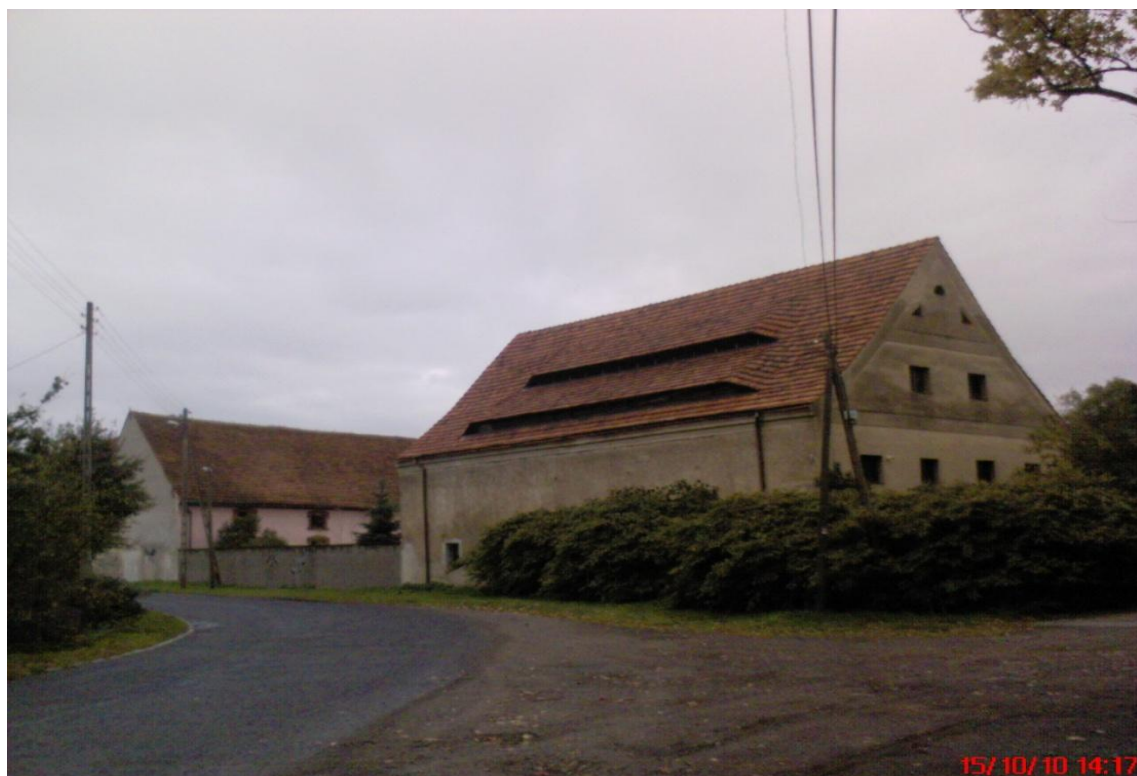
Zdjęcie nr 13. Warmątowice – budynek gospodarczy przy pałacu.
