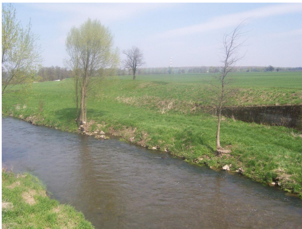
Zdjęcie 12. Widok z mostu na rzece Kaczawie na drodze z Wilczyc do Duninowa na rzekę Kaczawę (na horyzoncie widoczny komin Huty Miedzi Legnica)
