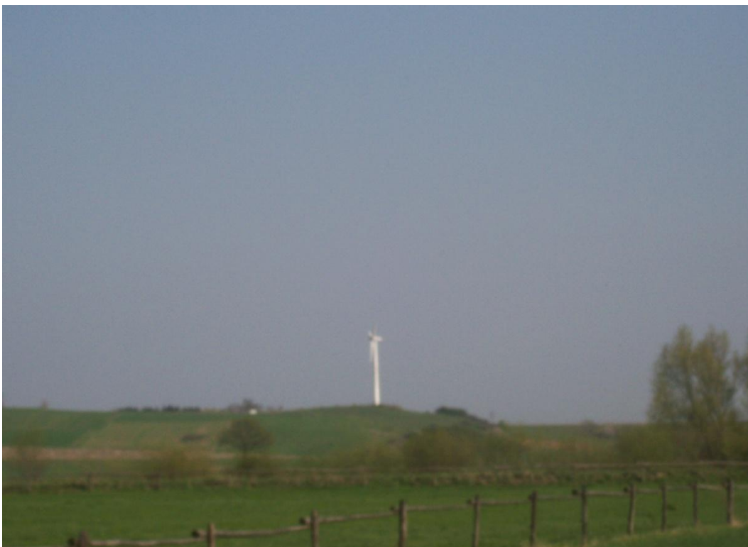
Zdjęcie 20. Widok na elektrownie wiatrową z drogi na końcu wsi Winnica w kierunku wsi Słup
